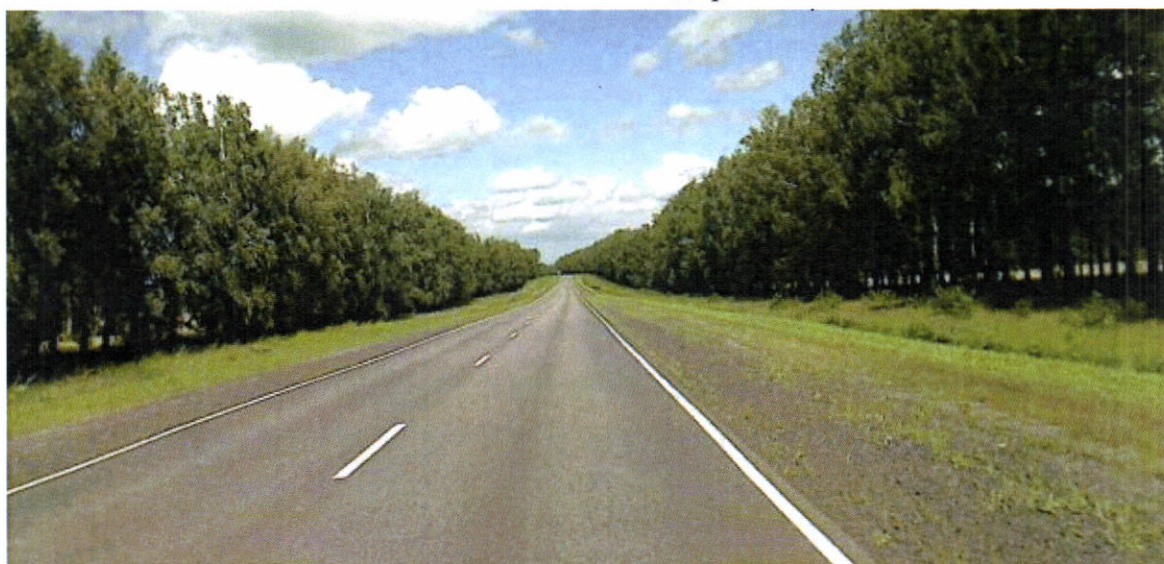
Рисунок 4 – Пример 2 размещения снегозащитных лесных насаждений вдоль автомобильных дорог
