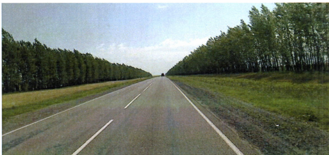
Рисунок 3 – Пример 1 размещения снегозащитных лесных насаждений вдоль автомобильных дорог
