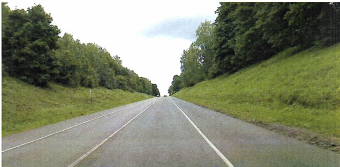
Рисунок 5 – Пример 3 размещения снегозащитных лесных насаждений вдоль автомобильных дорог
