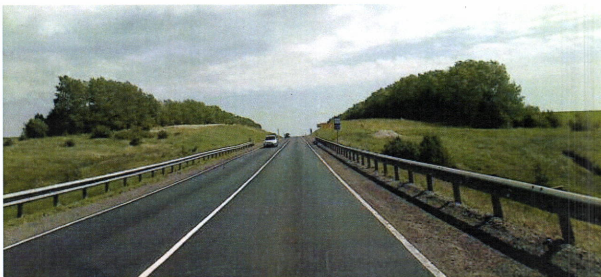
Рисунок 16 – Парные посадки деревьев на выпуклых переломах продольного профиля
