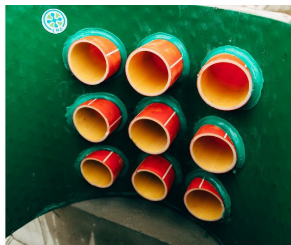
рис.1 «Общий внешний вид кабельных колодцев с установленными кабель-каналами»
