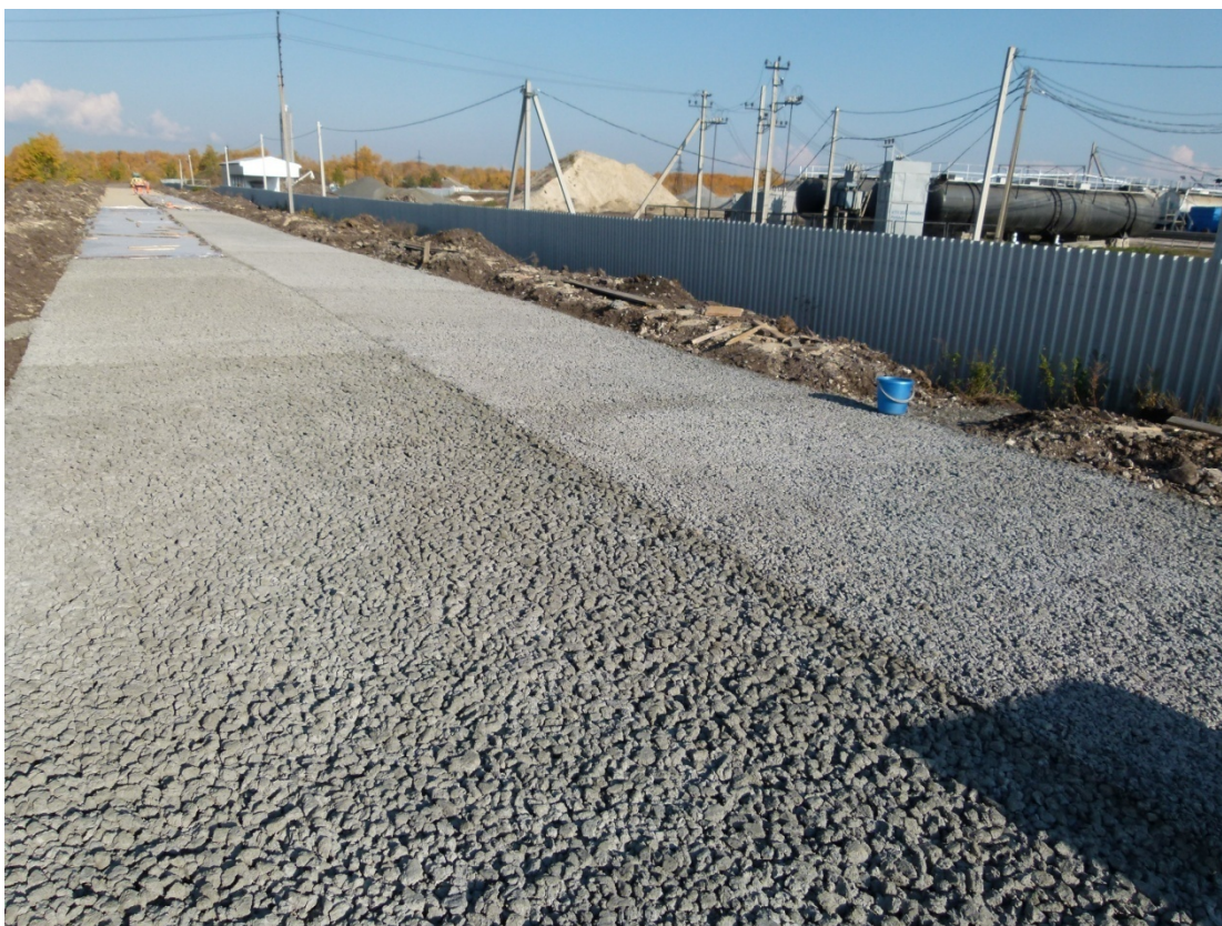
Рис 6. Слой покрытия автомобильной дороги, выполненный из крупнопористого дренирующего бетона КАПСИМЭТ. Пос. Цельна, Ульяновской области, 2014 год
