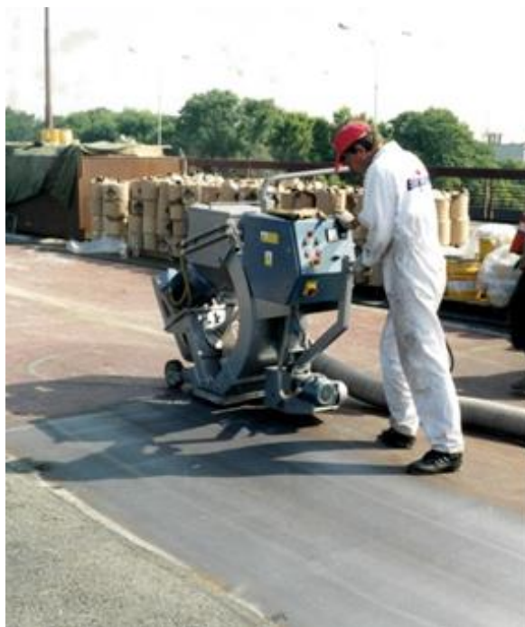
Рисунок 8 – Дробеструйная очистка поверхности металла аппаратом «Vlastrac»
