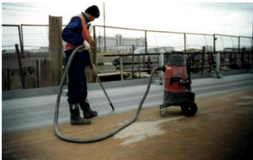
Рисунок 9 – Удаление продуктов дробеструйной очистки промышленным пылесосом
